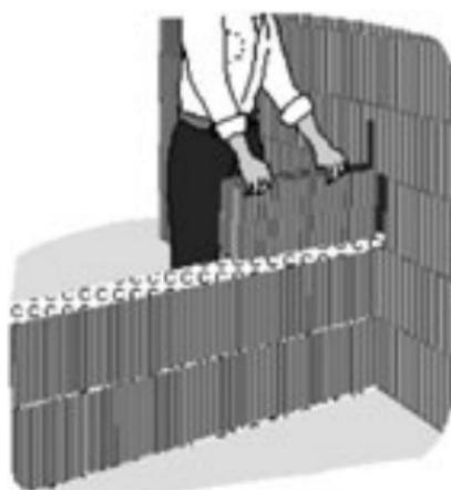
При соединении перегородки с несущей стеной на торцы блоков **POROTHERM 12** нанесите раствор, уложите их и прижмите к несущей стене. При таком типе стыка необходимо укреплять каждый второй постельный шов с помощью плоского анкера из нержавеющей стали (например, с помощью анкера FD KSF компании «Фишер» (FISCHER)). Согнутую под прямым углом горизонтальную часть анкера нужно вдавить в раствор постельного шва, а вертикальную часть – прикрутить с помощью шурупа и дюбеля к несущей стене.
